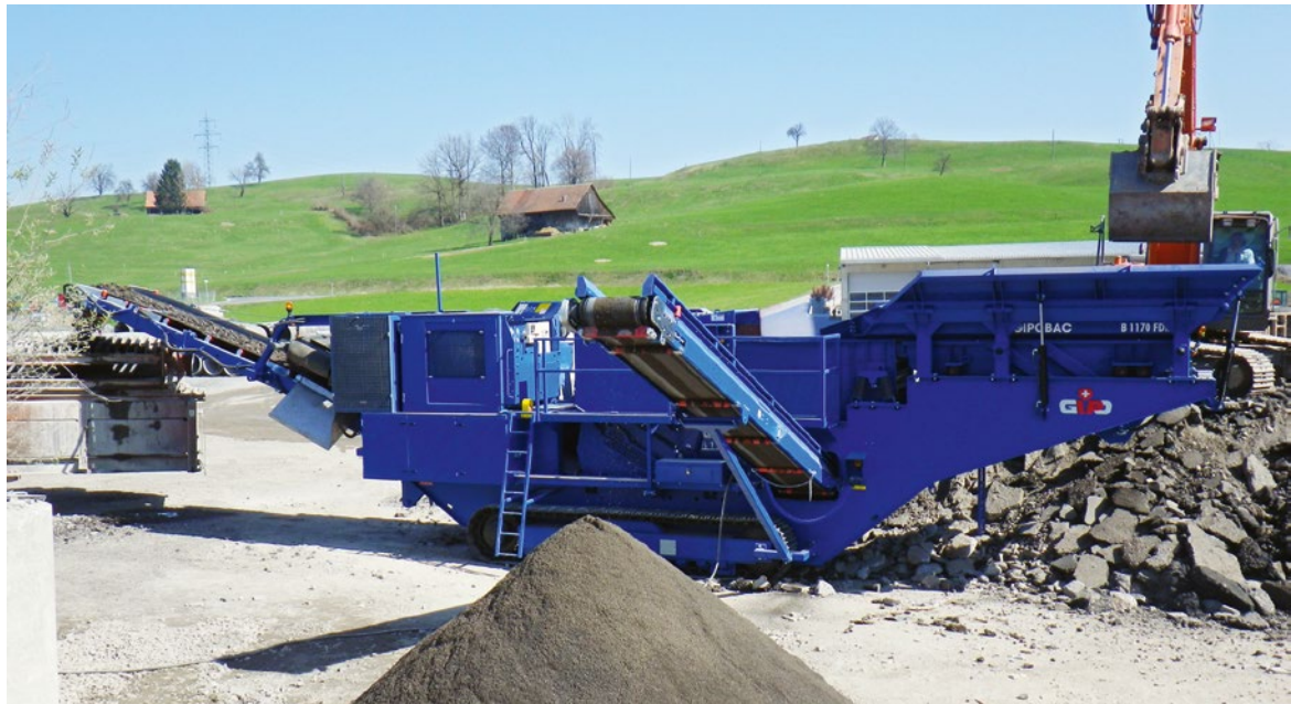
B 1170 FDR, Einsatz im Belagsabbruch
