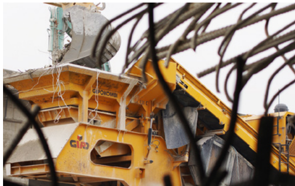
Komplette Materialaufbereitung direkt beim Abbruchobjekt/Complete material treatment directly at the demolition object/Traitement complet du matériau directement au niveau de l'objet de la démolition
